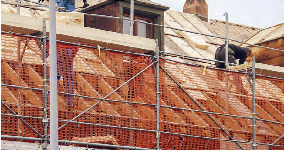
Die Dächer werden abgedeckt und isoliert
