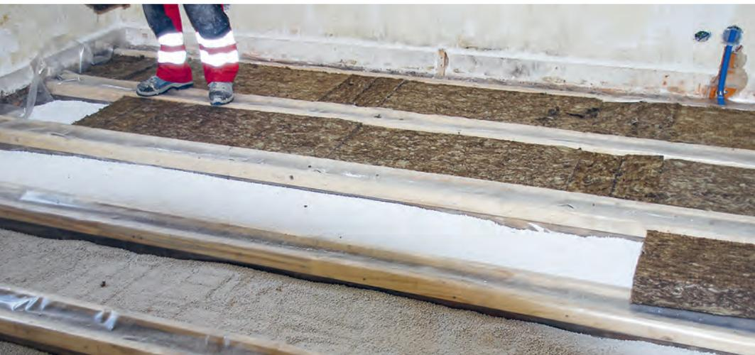
Nivellierungsgranulat und Dämmungsmatten
